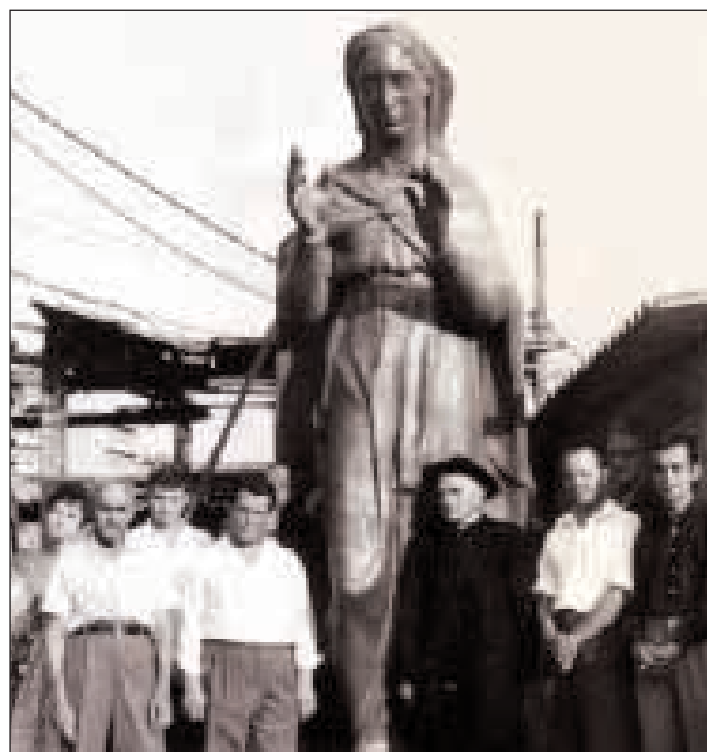
Nel cantiere con don Paolo e il Sabbatani
