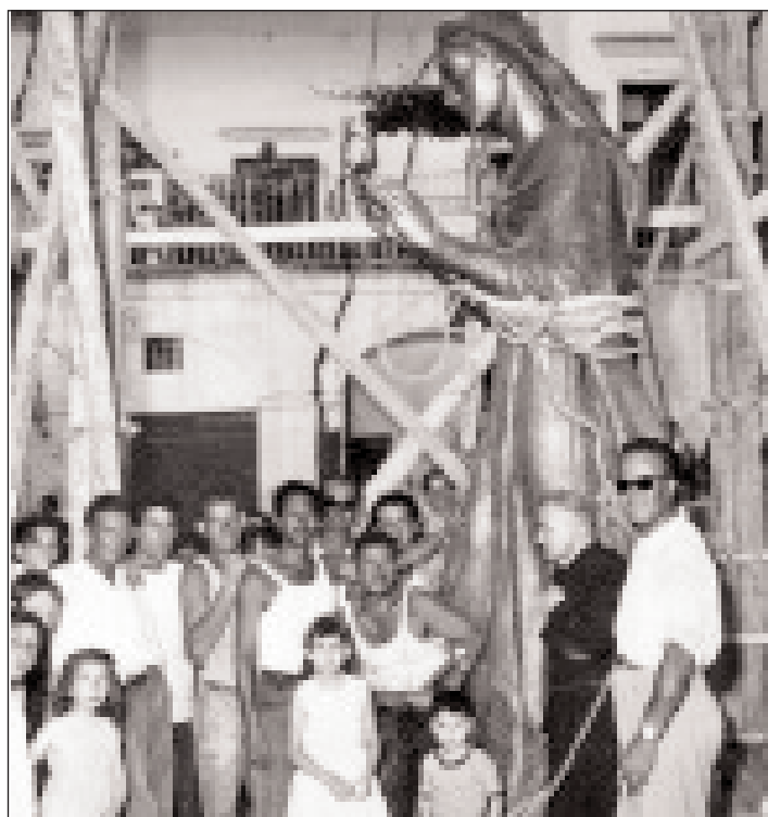
25 luglio del 1959 ultimi preparativi nel cantiere prima della posa
