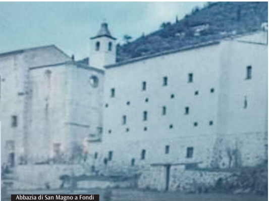
Abbazia di San Magno a Fondi
