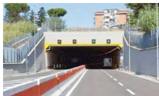
Una galleria della nuova tangenziale, che dovrebbe alleggerire il traffico
