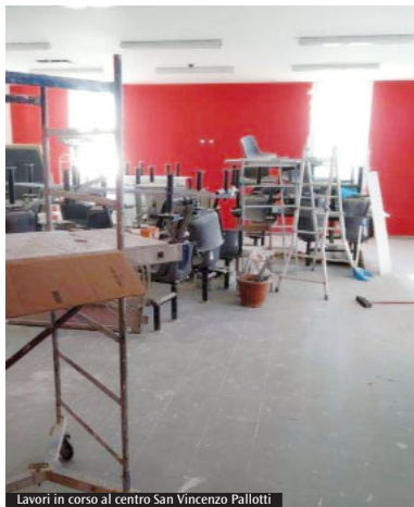
Lavori in corso al centro San Vincenzo Pallotti
