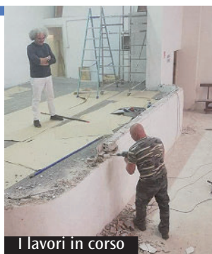
I lavori in corso
